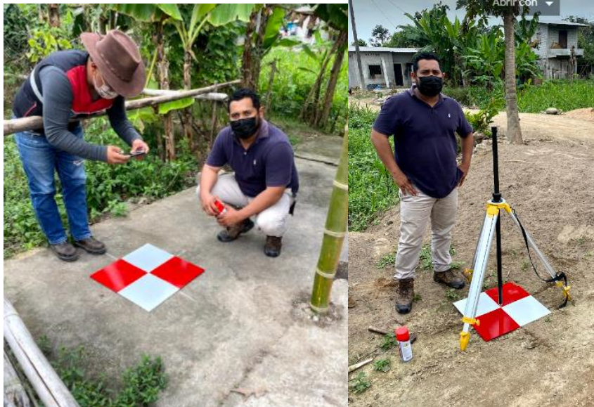
Ilustración 4: Lectura de coordenadas del punto atrás.
