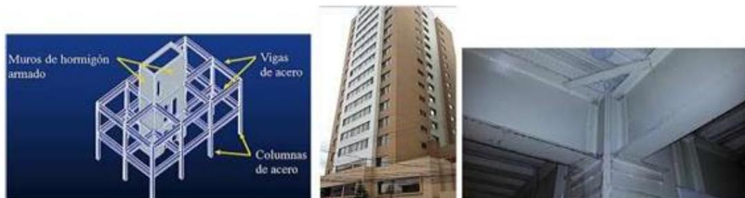
Pórticos de acero con paredes de mampostería (S5): Pórticos de acero laminado en caliente con paredes divisorias de mampostería de bloque de hormigón.
