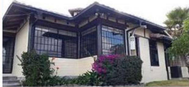
Mampostería sin refuerzo (URM): Muros de paredes portantes de ladrillo, bloque, adobe, bahareque, sin refuerzo de varillas de acero.
