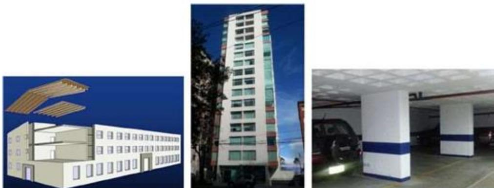
Pórticos de hormigón armado con mampostería confinada sin refuerzo (C3): Elementos estructurales vigas y columnas de hormigón armado y muros portantes de mampostería sin varillas de acero.
