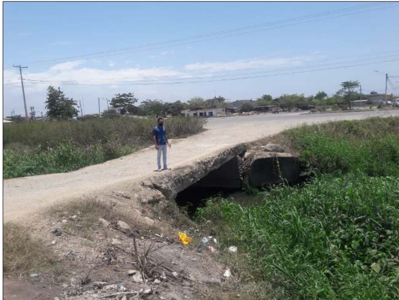
Figura 4. Puente provisional de empresa privada aledaña.
