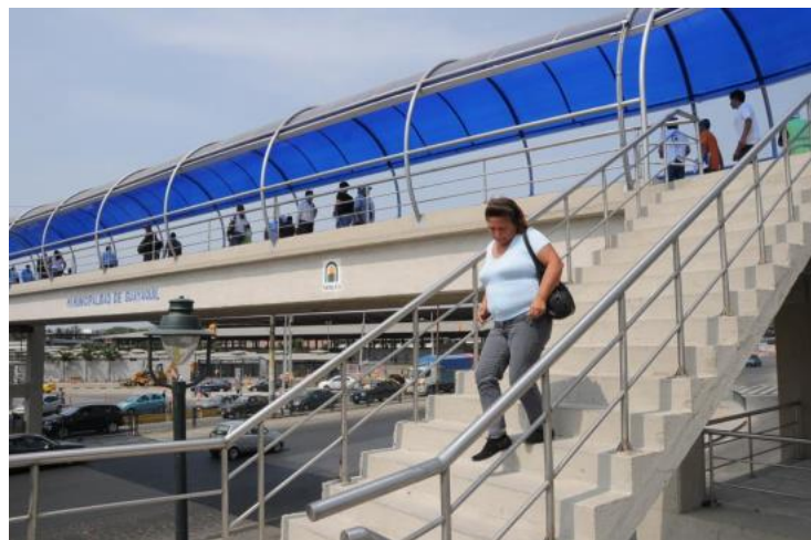
Figura 2. Puente peatonal, ubicado en el terminal terrestre de Guayaquil
