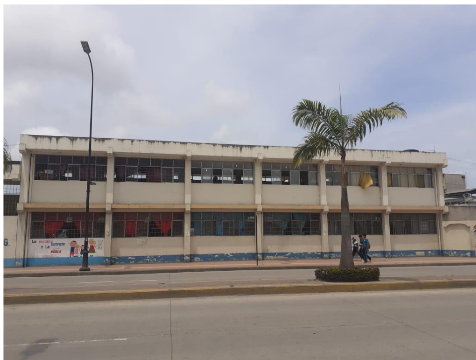
Anexo 2: Vista Posterior del bloque de aulas de la Esc. Diego Minuche G.
