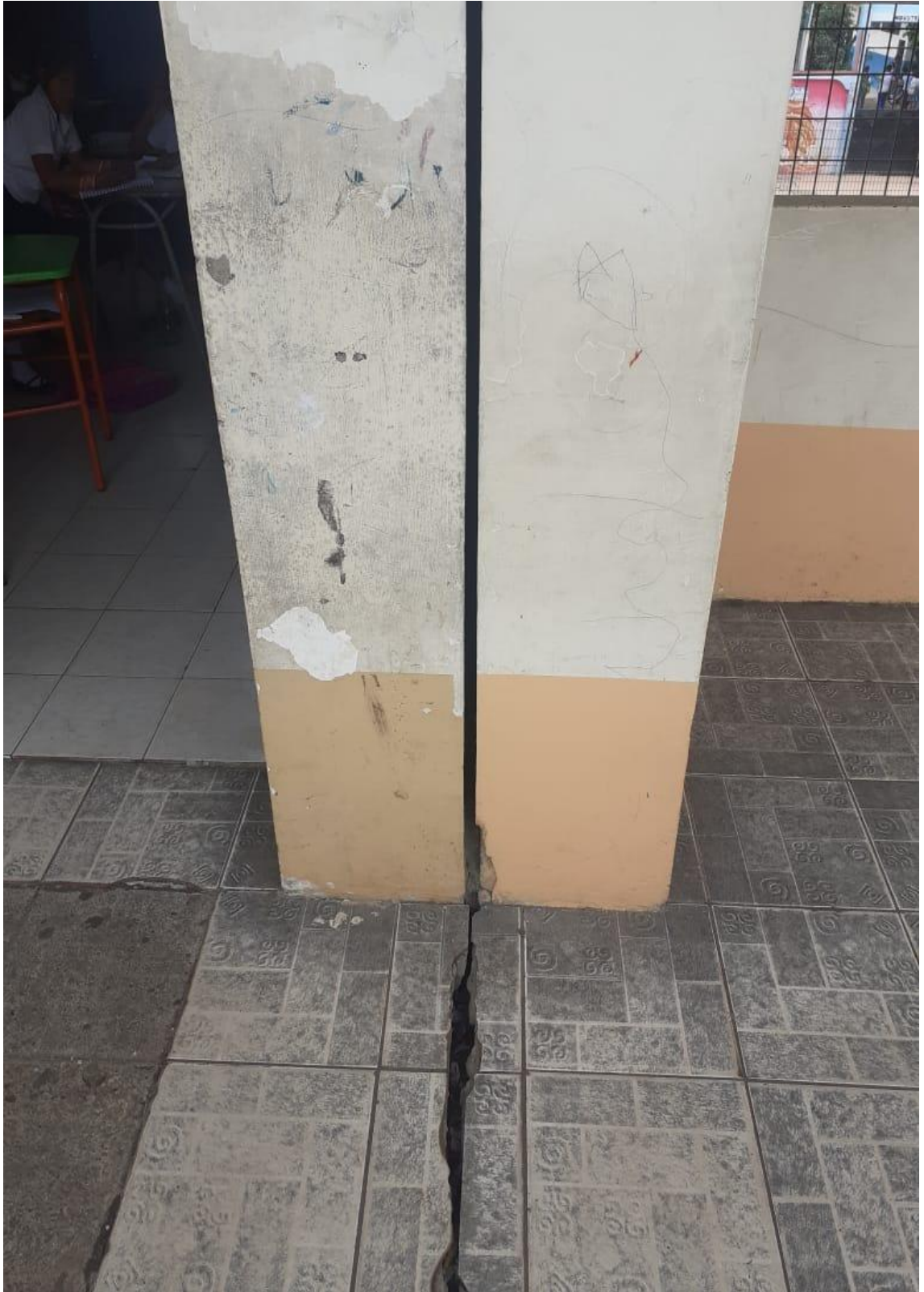
Anexo 7: Juntas de Construcción
