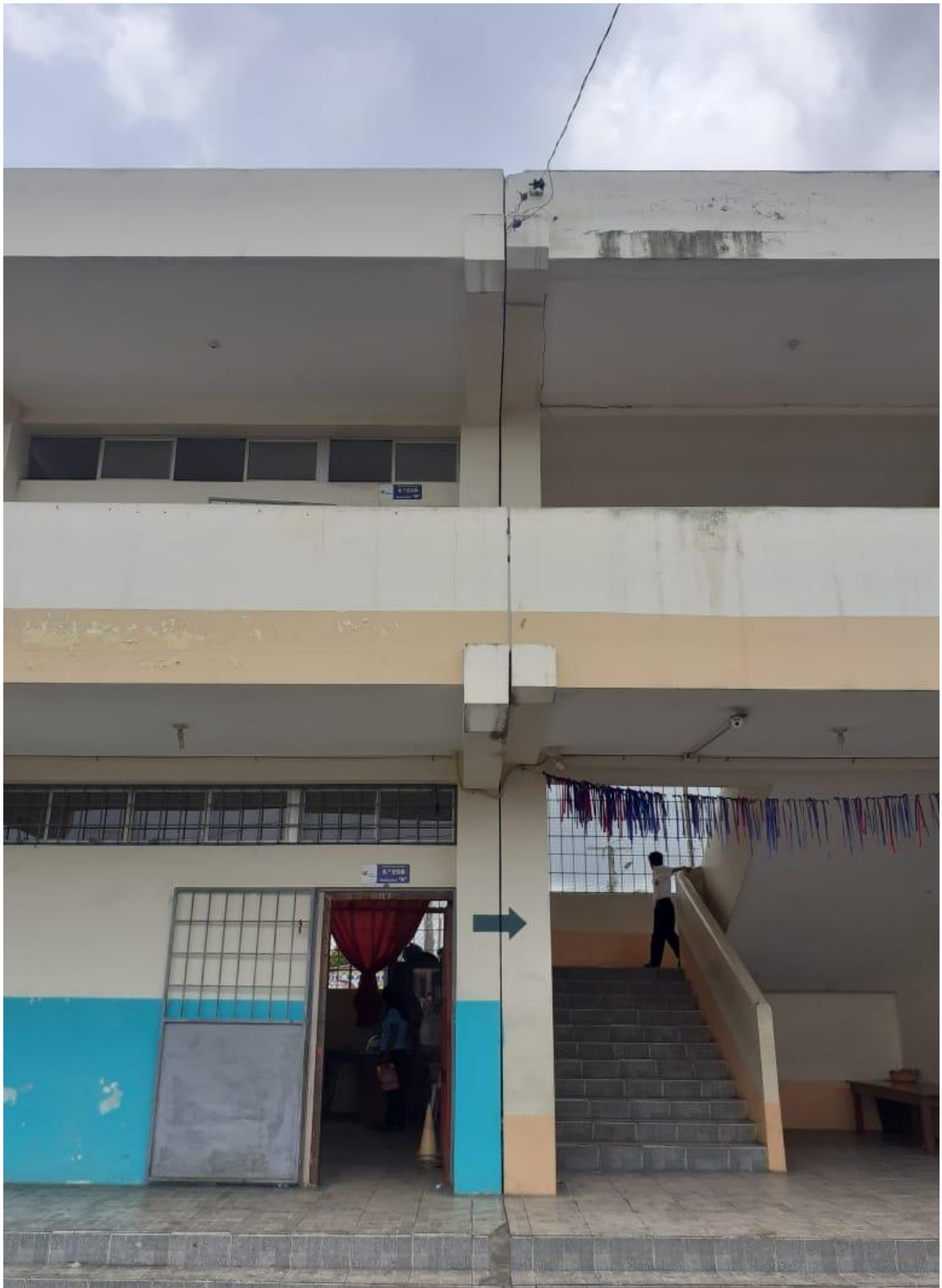
Anexo 3: Visualización de columnas y vigas peraltadas.
