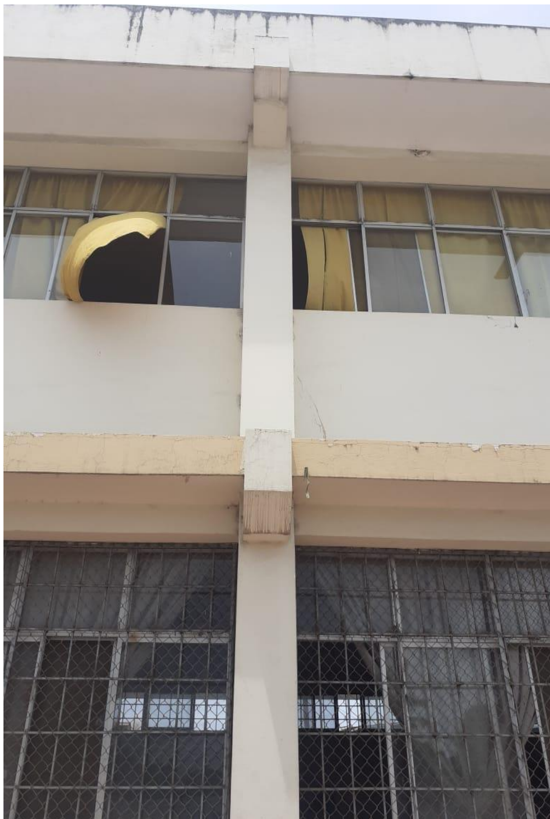
Anexo 4: Columna y viga exterior peraltada
