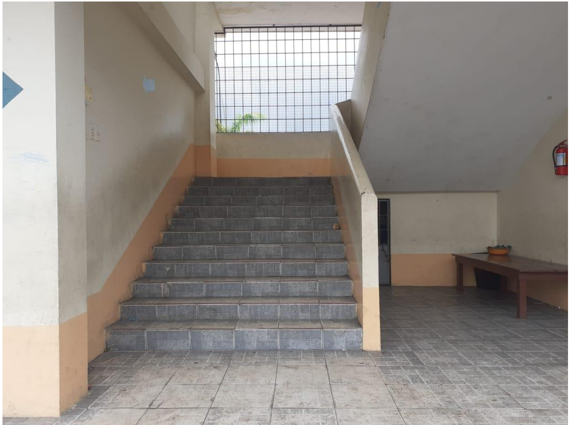
Anexo 5: Acceso a escaleras
