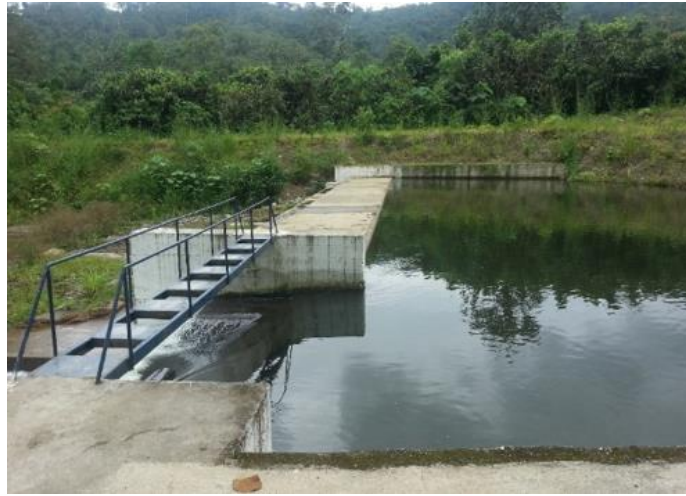
Figura 2. Captación en el río Casacay
