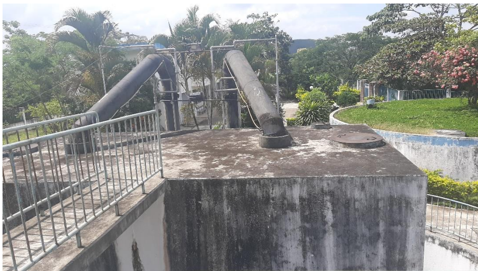
Filtro de gravedad autónomos sin válvula de la planta de tratamiento de agua potable de Portovelo
