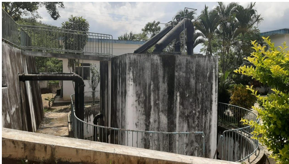
Filtro de gravedad autónomos sin válvula de la planta de tratamiento de agua potable de Portovelo
