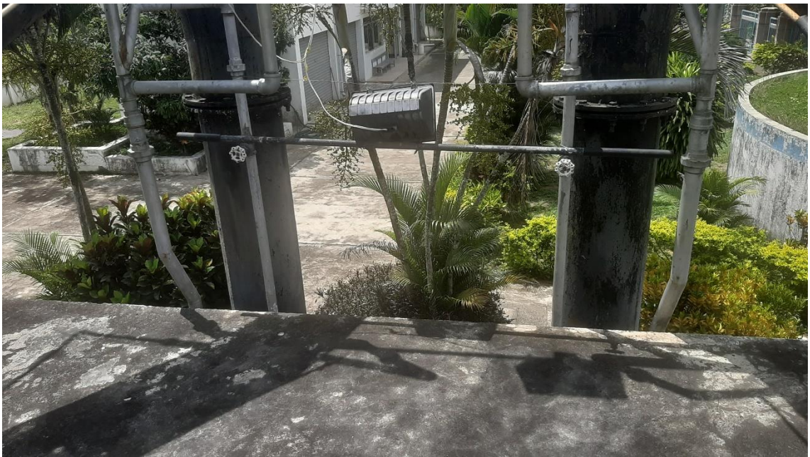
Sistema tipo sifón encargado del lavado automático de los filtros
