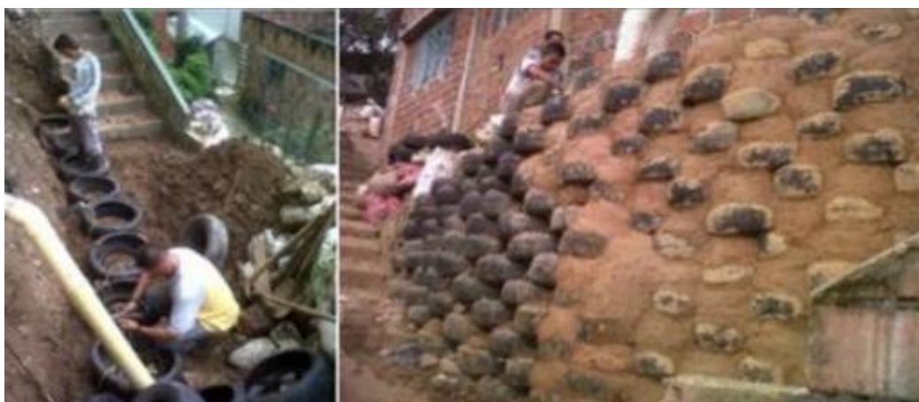
Figura 1. Barrio Fuente Clara – Medellín Colombia, Construcción de Muro con Llantas Recicladas.
