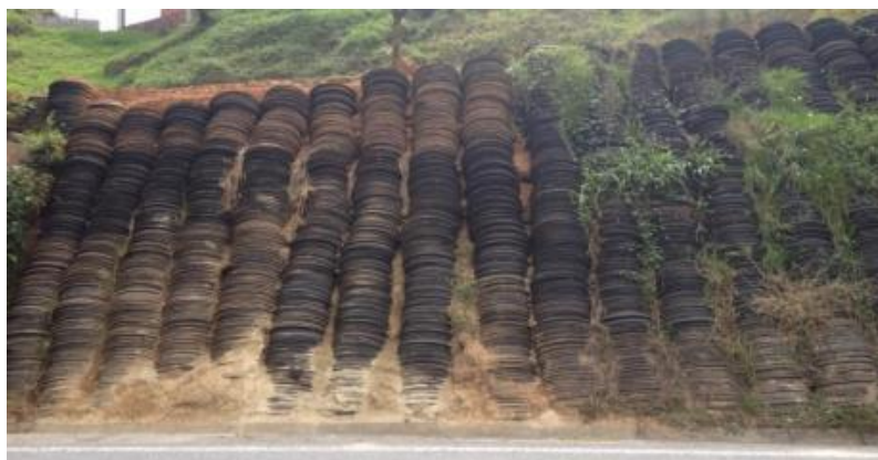
Figura 28. Muro construido con aros de las llantas.
