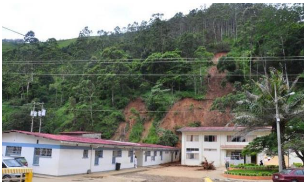
Figura 5. Deslizamiento de tierra al pie del talud del cerro Pata Grande.
