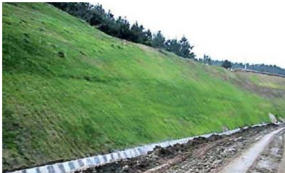
Figura 2. Vegetación colocada en talud estabilizado.
