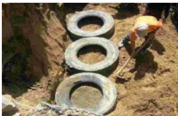
Figura 29. Conformación y nivelación del terreno.
