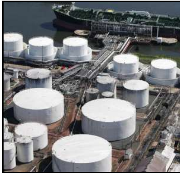
Ilustración 1. Terminal de combustible.
