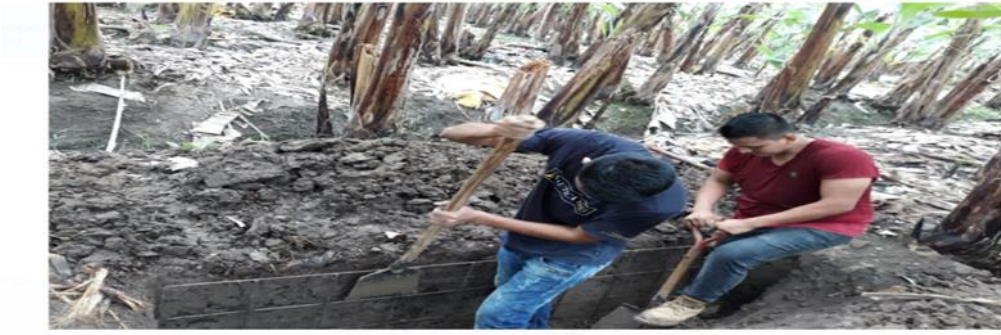
Anexo 1.- Realización de la calicata de con una profundidad de 0,60 cm y ancho de 2 m.
