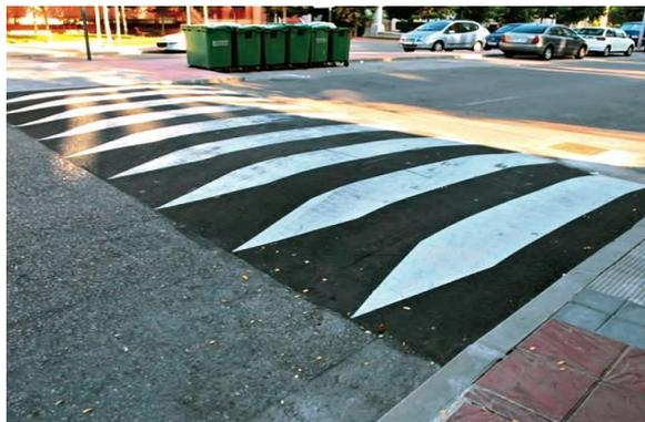
*Fig. 8: Resalto de Asfalto o concreto*
