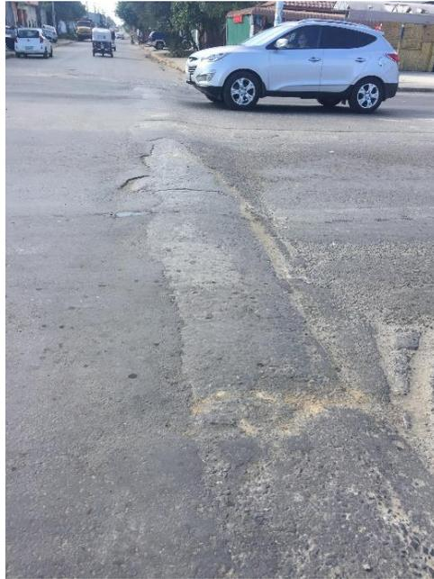
*Fig. 14: Deterioro del Reductor de Velocidad tipo Resalto, ubicado en Av. La República y calle Pasaje
