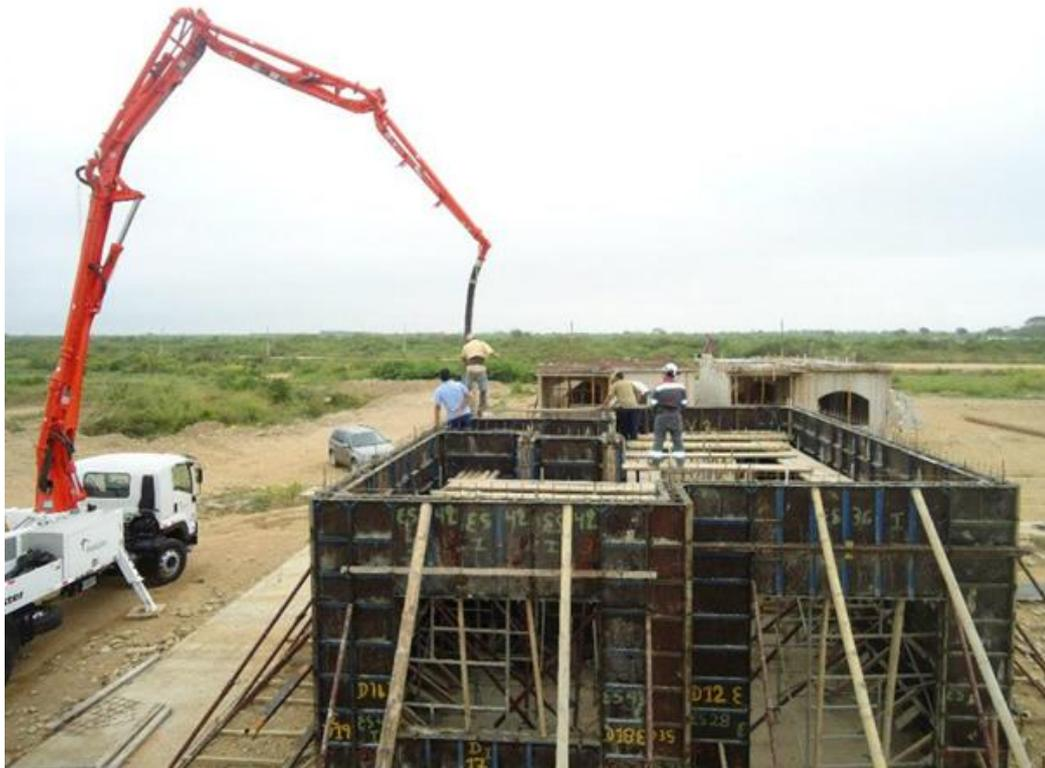
**Figura 6.** Construcción de sistema muros portantes de hormigón armado.
