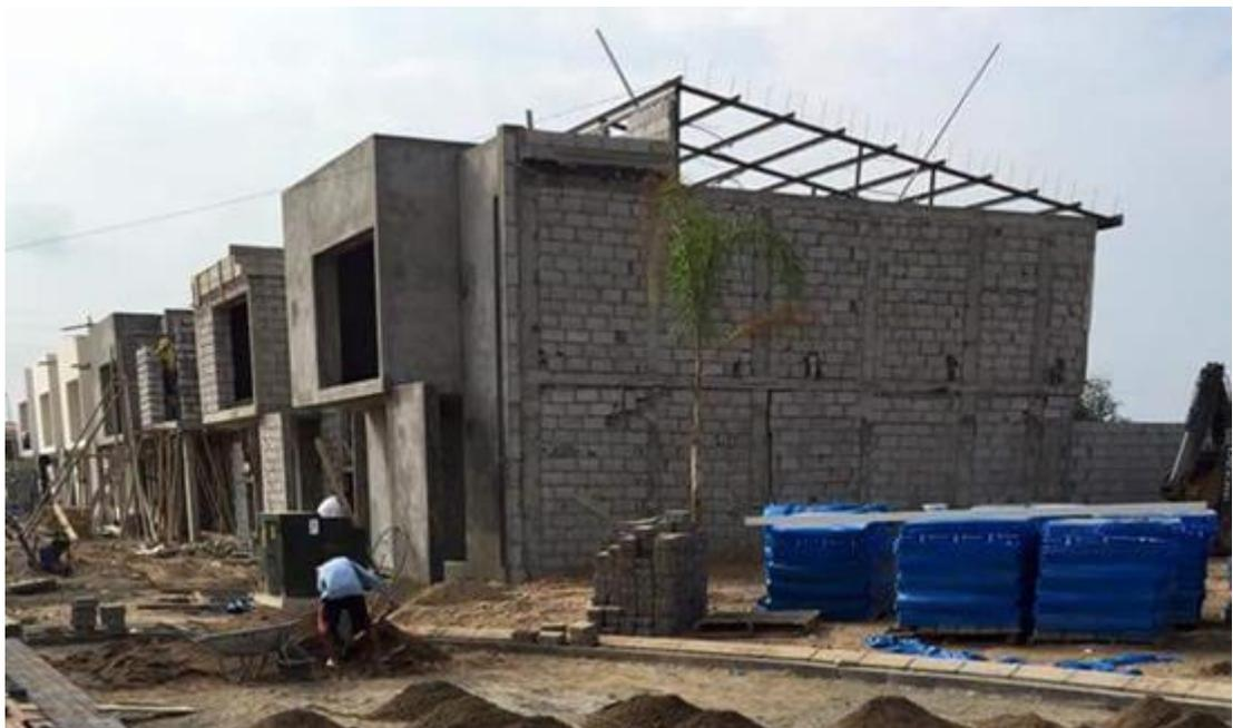
**Figura 4.** Construcción de sistema tradicional tipo pórtico.
