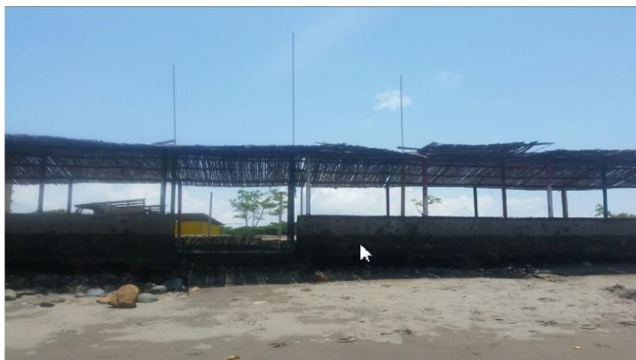
Figura Nro 15 Contrucción de escalinatas
