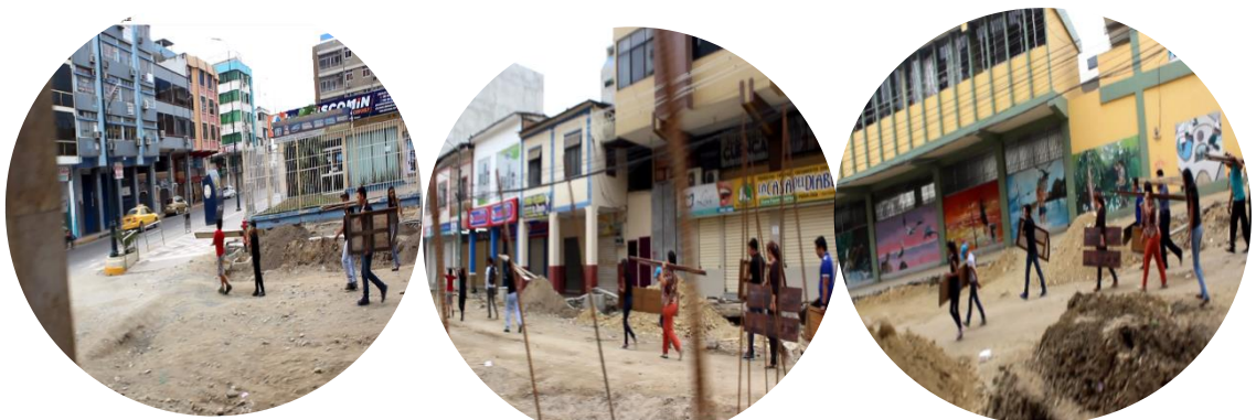
Imagen 17. Seguimos avanzando por la calle 25 de junio en proceso de regeneración. Fuente del autor. 20/07/2016
