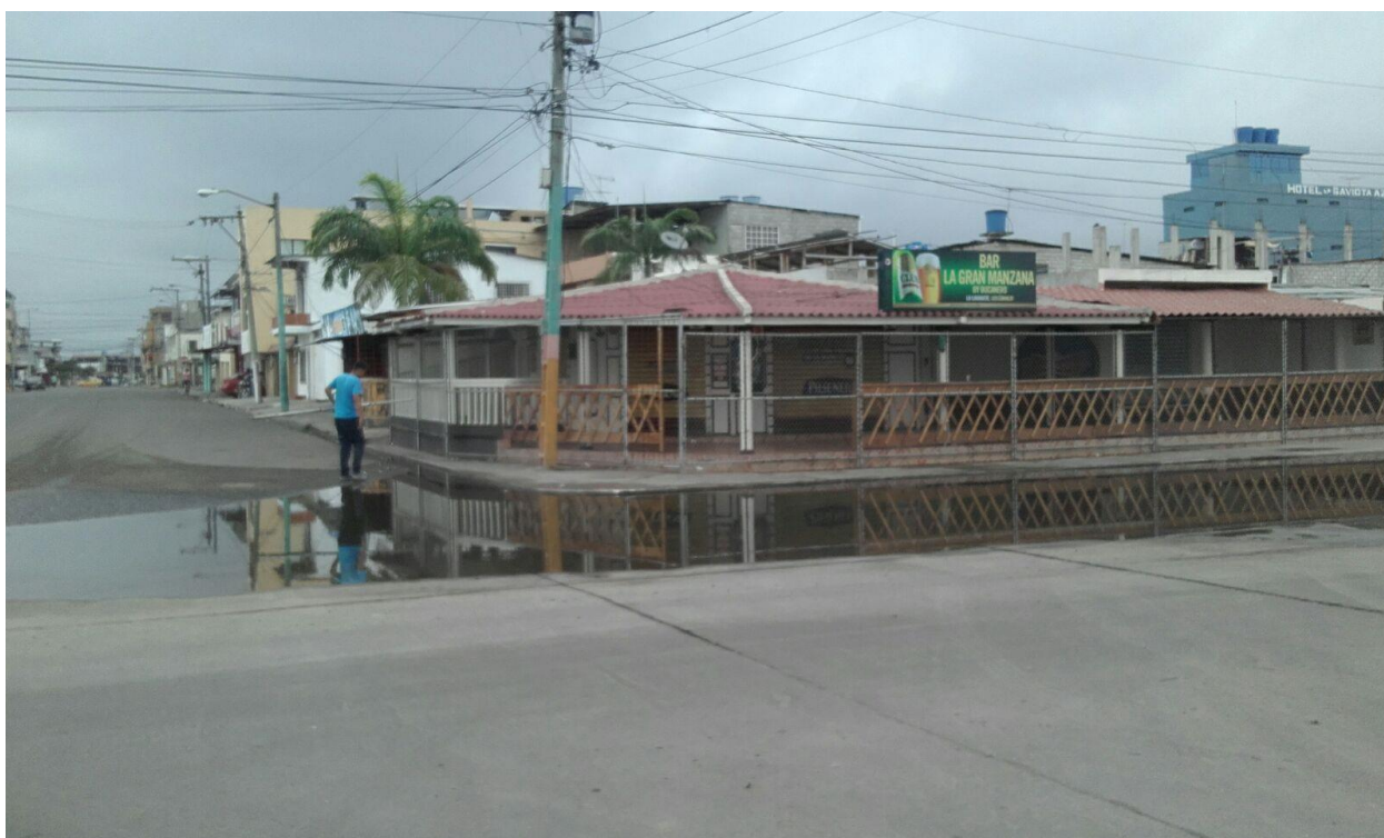
Área frente al restaurante de Pepe's el agua se queda debido a que la vía es más baja respecto a las otras vías transversales
