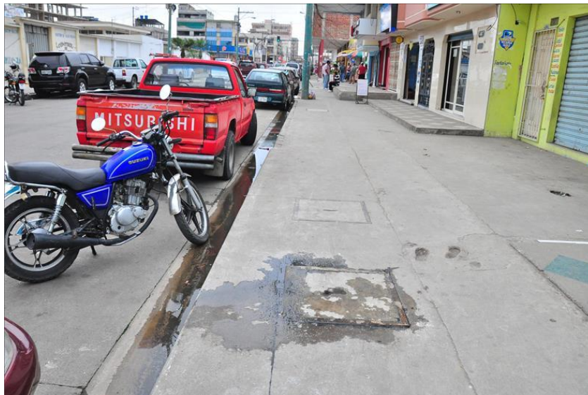
Grafico 9 En las calles Tarqui entre Guabo y Boyacá, una alcantarilla está rebosante de aguas servidas que además tiene una filtración de agua entubada, los malos olores ocasionan malestar en el sector comercial y peatones.
