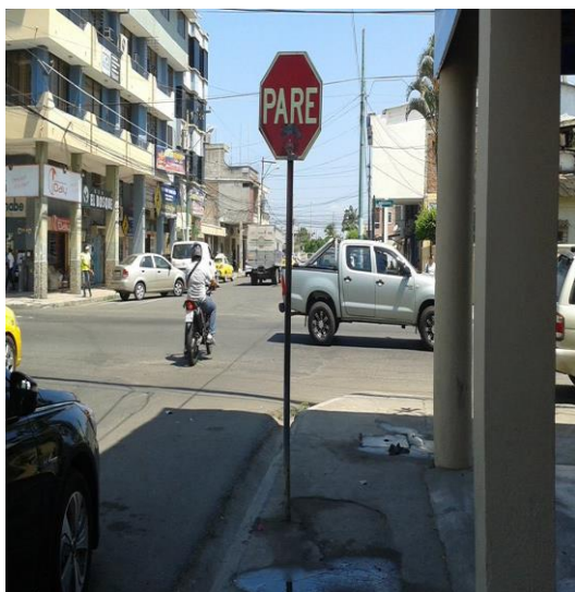
Mal estado de las señales.
