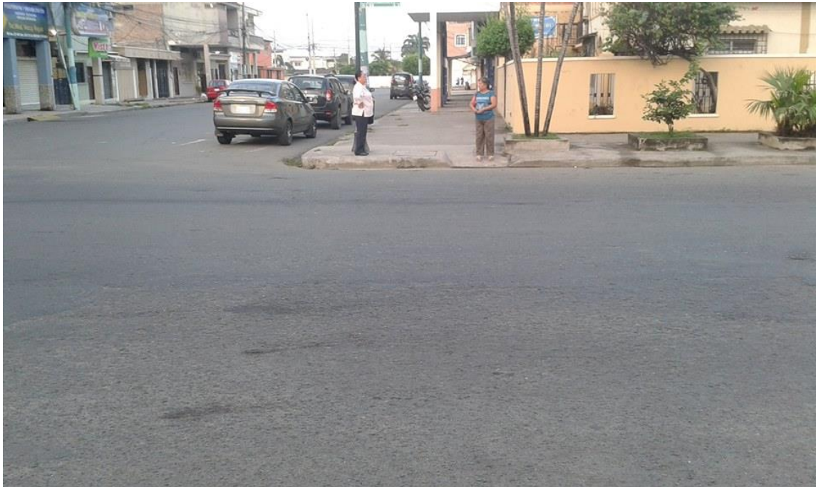
Anexo 10. Falta de pasos cebra en las intersecciones.
