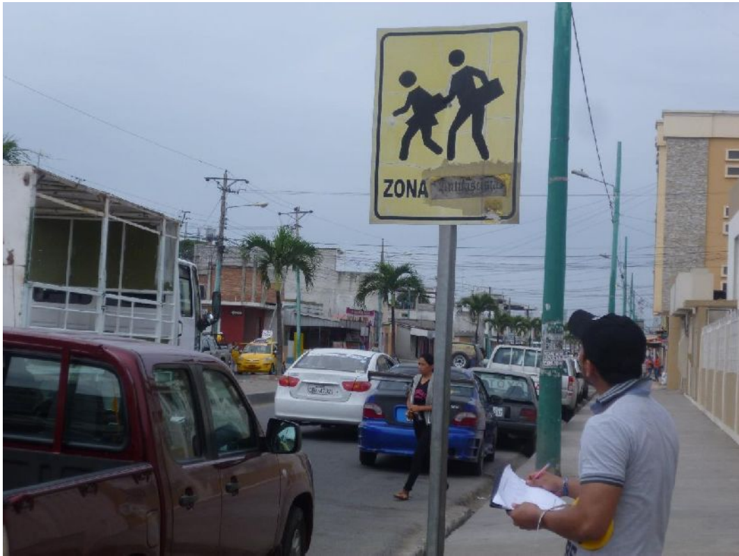
Anexo 3. Señal vertical preventiva "Zona escolar" deteriorada (Fuente: El Autor – 2015)
