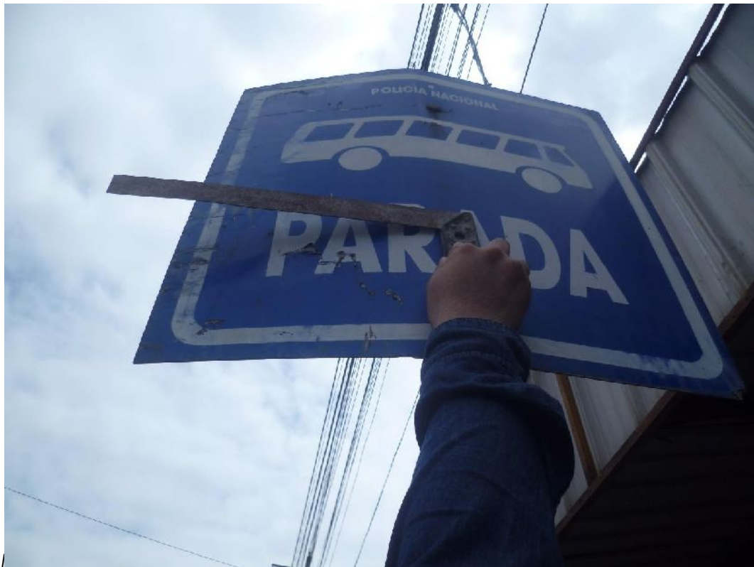
Anexo 6. Deformación de señal vertical regulatoria “PARADA DE BUS” (Fuente: El Autor – 2015)
