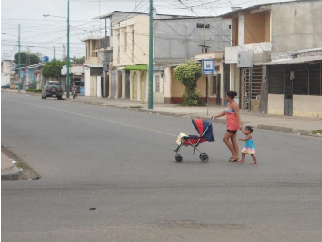
Anexo 7. Ausencia de señalización horizontal en intersecciones (Fuente: El Autor 2015)
