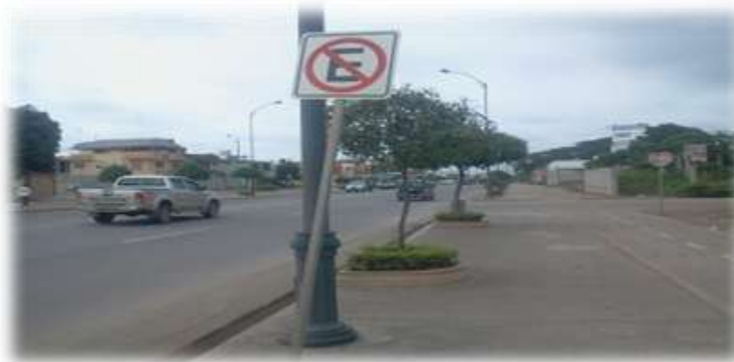
Grafico 7: Es claro notar que esta señal se encuentra con una mala inclinación esto puede ser por mala instalación o por accidente ocasionado por conductores
