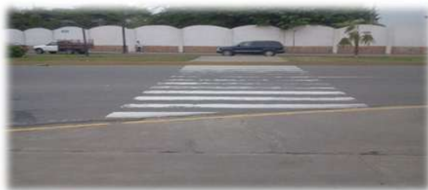
Grafico 2: El uso del paso de cebra se presenta desgastes en su pintura
