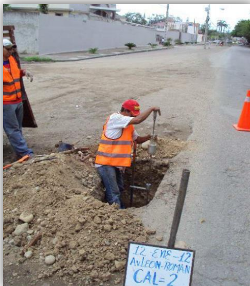
Gráfico 5. Extracción de calicatas. Fuente: GAD Machala
