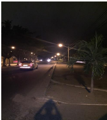
Gráfico 9. Estado de luminarias O-E. Fuente: El autor.
