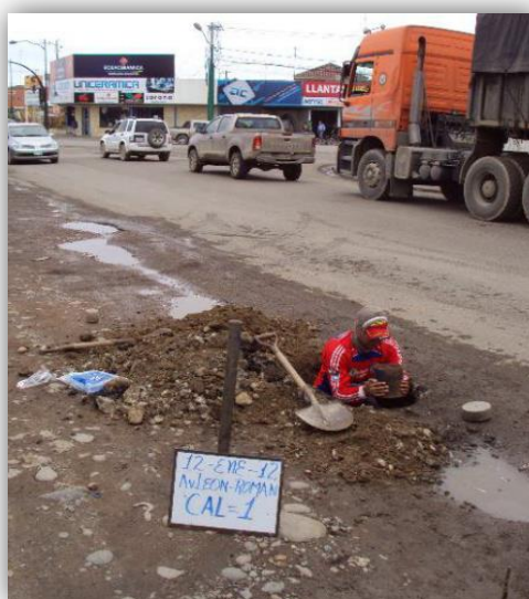
Gráfico 4. Extracción de calicatas. Fuente: GAD Machala
