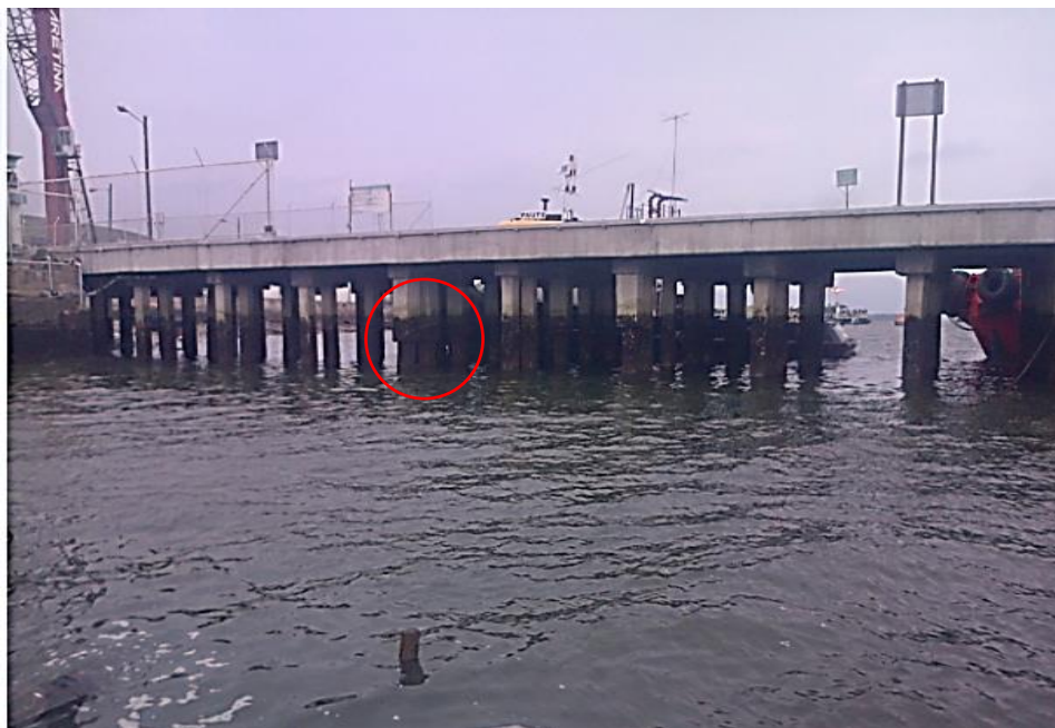
Anexo N° 2. Vista de los pilotes encamisados del Muelle de Espigón
