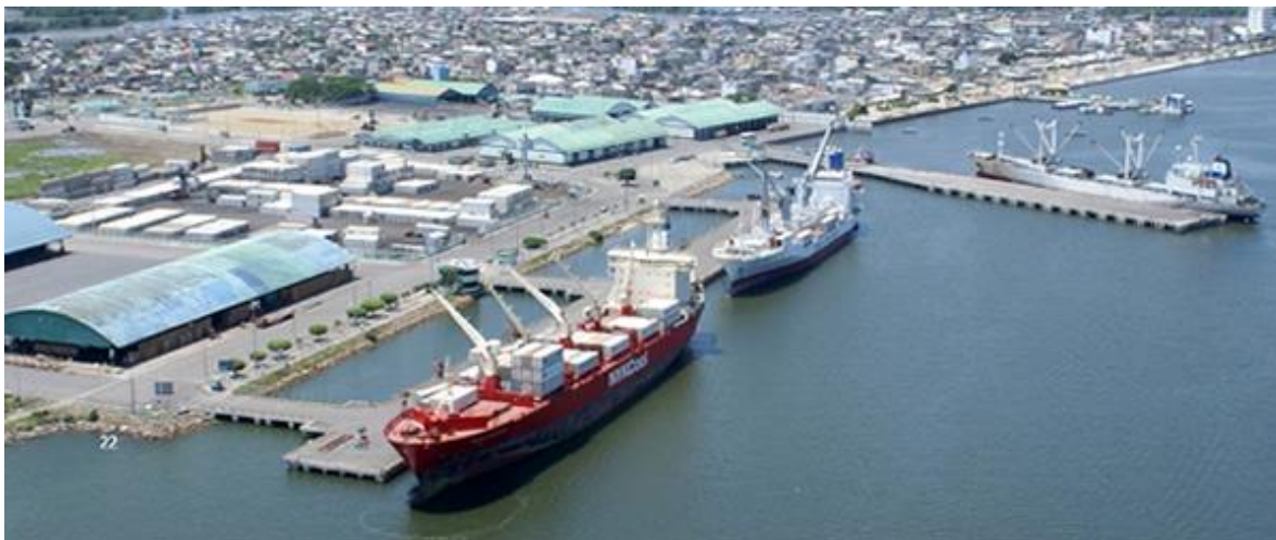
Anexo N° 1. Vista de Muelle de espigón y muelle marginal
