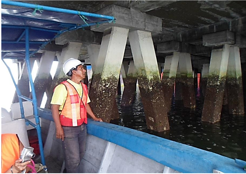
Anexo N° 5. Observación de vigas y pilotes
