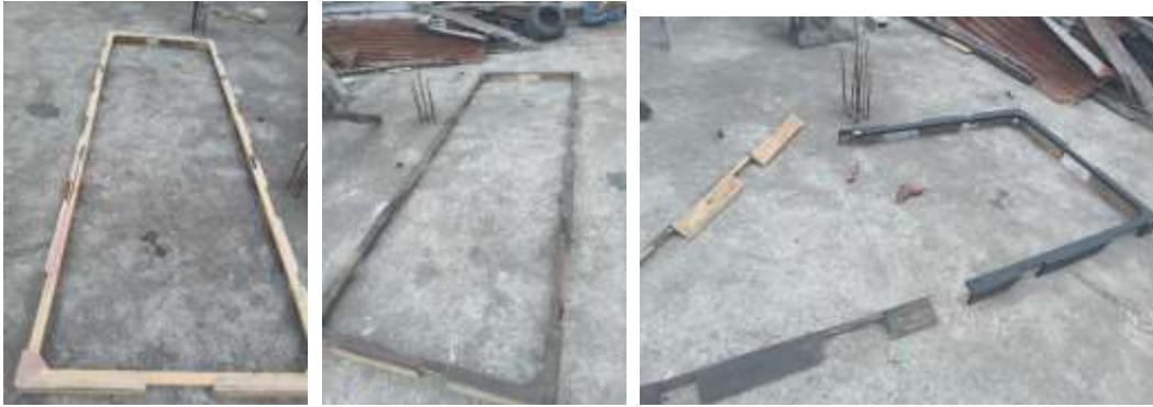
Ilustración 38 Avances de la obra Fuente del autor. 20/08/2023
