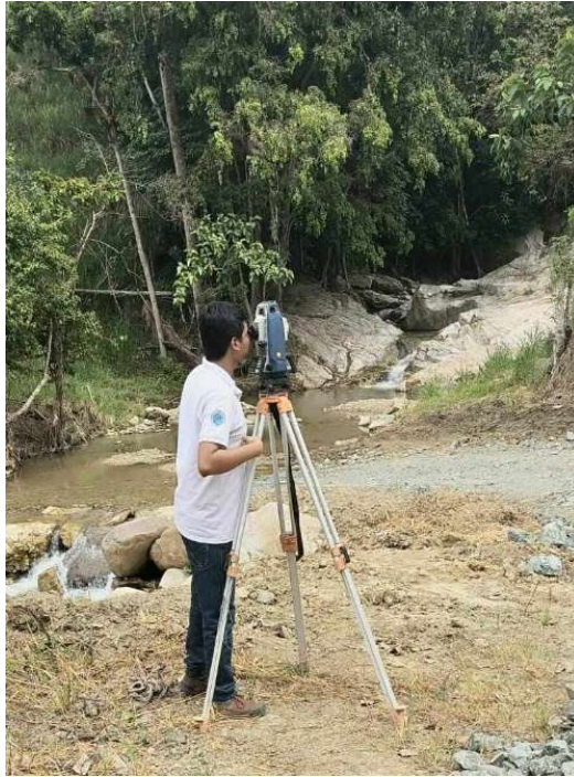
Ilustración 28: Realización de trabajo de campo en la quebrada “El Negro” – Evidencia 1
