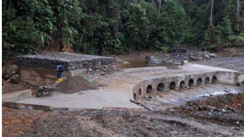
Ilustración 3: Puente tipo badén en la comuna Las Mercedes, provincia de Santo Domingo de los Tsáchilas
