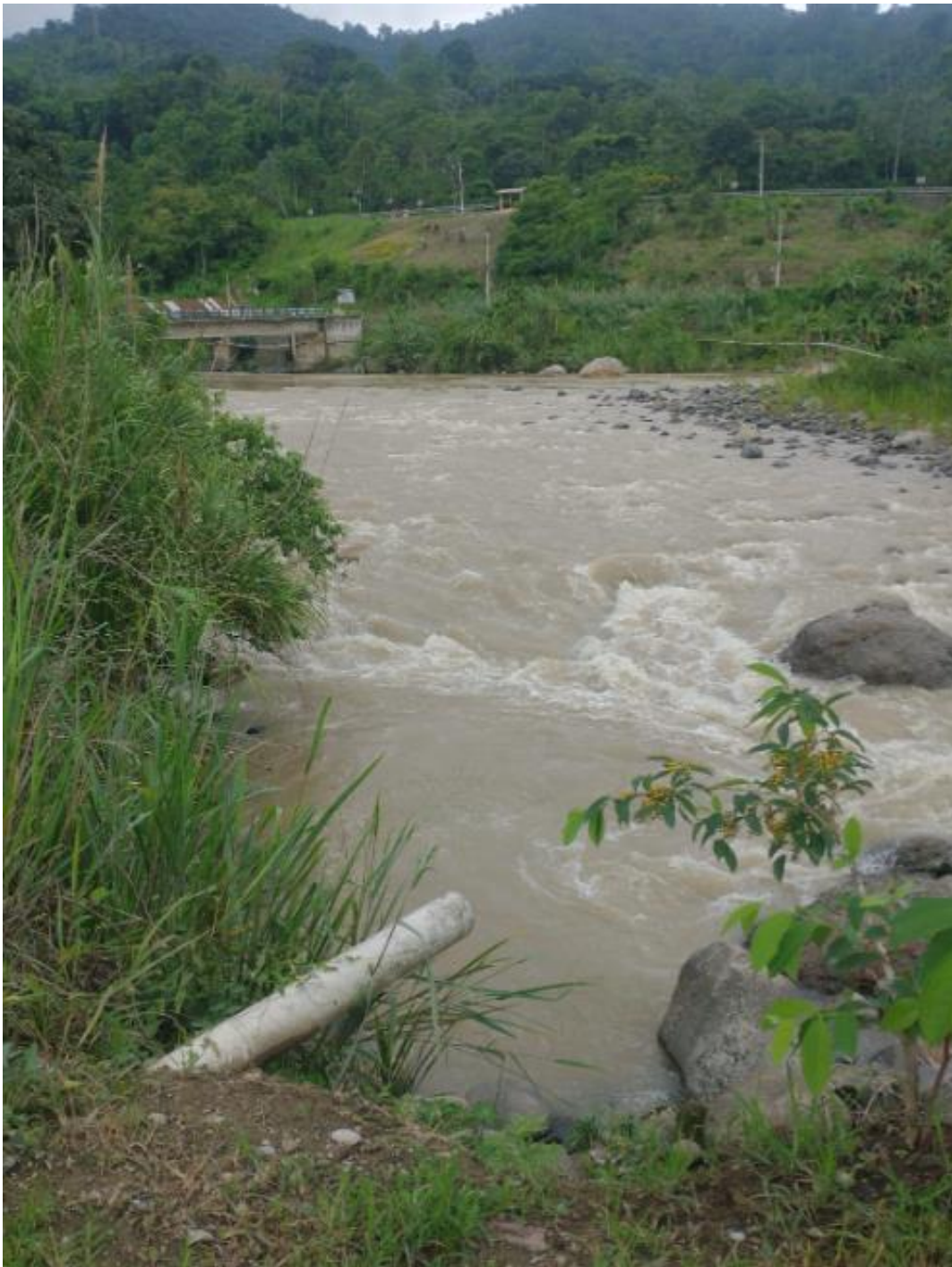
Ilustración 24: Tubería de descarga al Río Jubones
