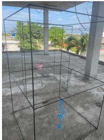
Ilustración 6. Jaulas recién soldadas
