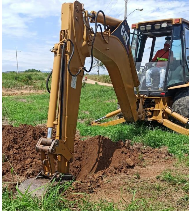
Ilustración 35 Extracción de calicata 1 con maquinaria
