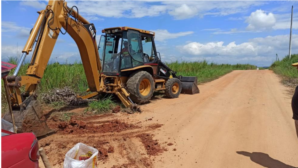
Ilustración 37 Extracción de calicata 2 con maquinaria
