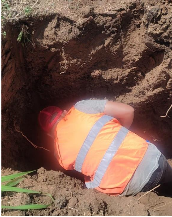
Ilustración 39 Extracción manual de calicata 3
