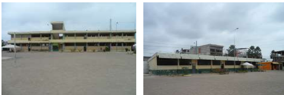
Imagen 2: Infraestructura de la Unidad Educativa Ciudad de Machala
