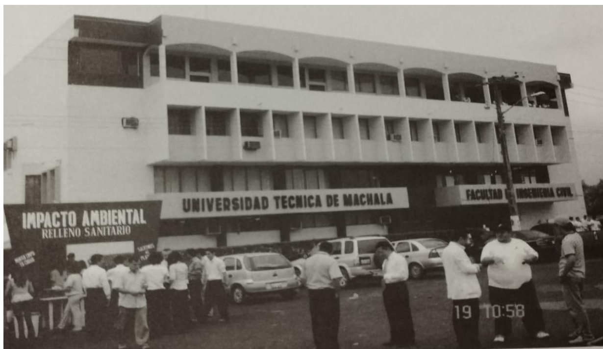
Figura 34. Facultad de Ingeniería Civil
