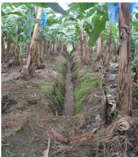
Construcción de la red de drenaje
