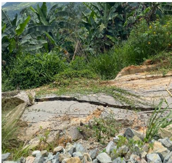
Deslizamiento de terreno de la estructura de pavimento en abscisa 5+660.000
