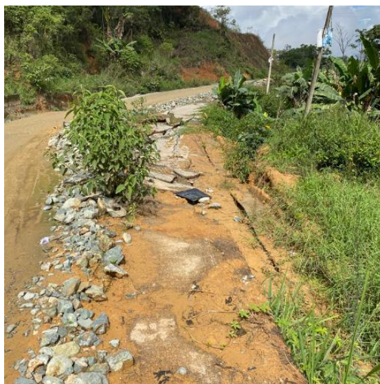
Deslizamiento de terreno de la estructura de pavimento en abscisa 5+660.000
