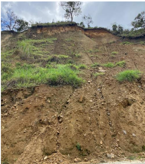
Figura 24 Derrumbe en abscisa 18+400.000
