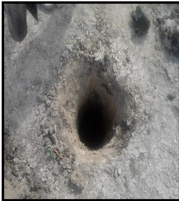
Anexo 5: Comienzo de la excavación de la calicata#1
