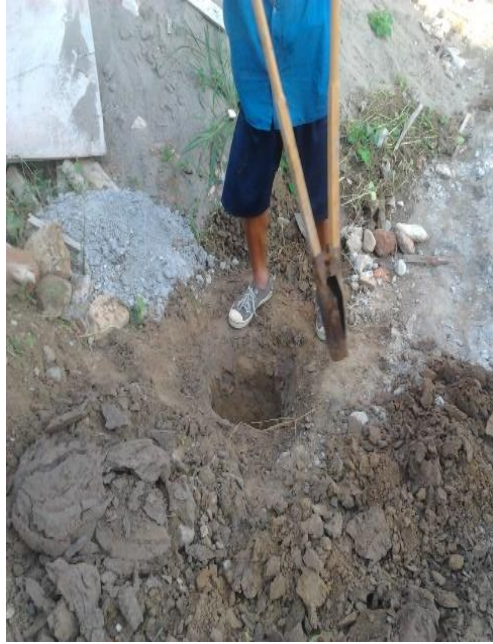
Anexo 6: Toma de calicata #2 en la vía
