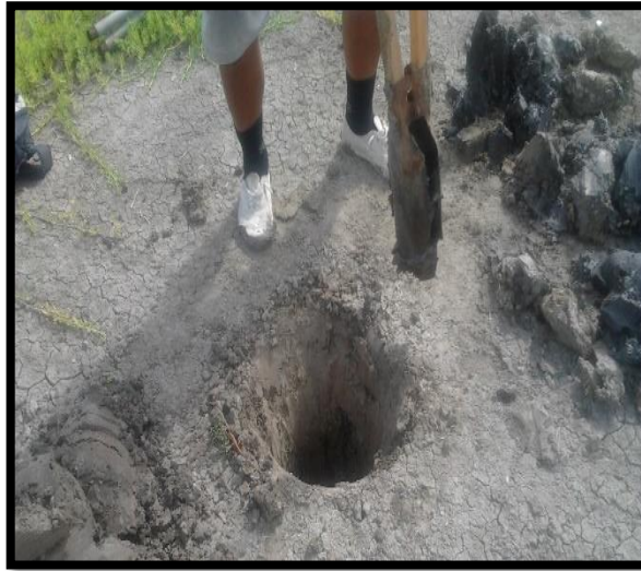
Anexo 4: Toma de calicata en la vía
