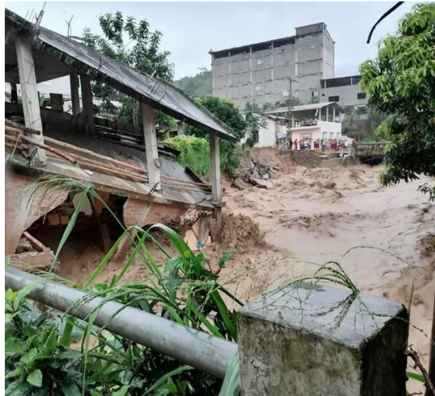
Ilustración 12. Colapso de vivienda por fuerza del agua
