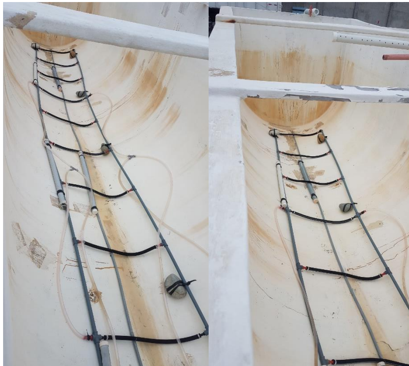
Anexo 6. Colocación del sistema con microporosa en los tanques
