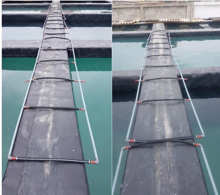
Anexo 4. Desinfección del sistema por luz solar
