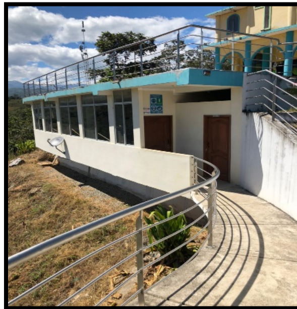
Ilustración 13. Espacio real de la planta baja del local
