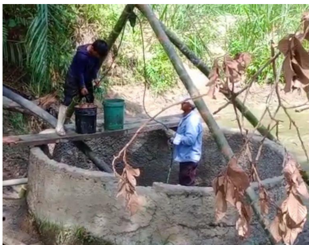
Figura 13. Realización de dragado en el pozo de agua.
