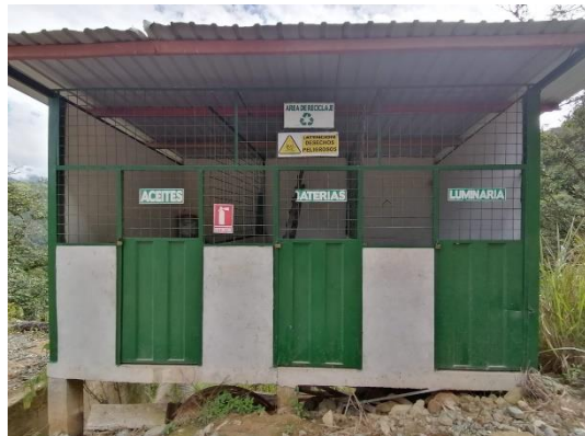
Almacén de Desechos Peligros
