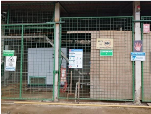
Area de compresores
