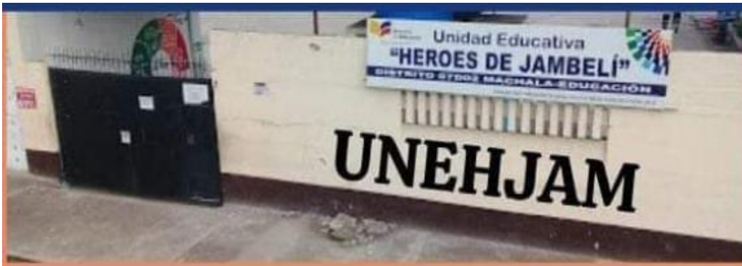
Ilustración 1. Vista de la institución.
