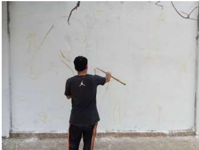
Imagen 14 Avance uno de la obra, 2022 Fuente de autores
