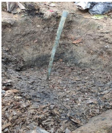
Figura 4. Elaboración de fosa para mezcla de materiales.
