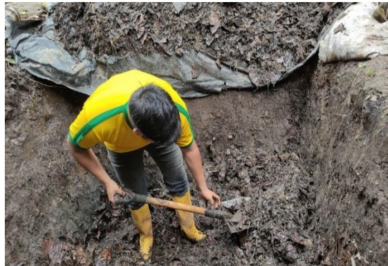
Anexo 2. Elaboración de fosa y mezcla de materiales.
