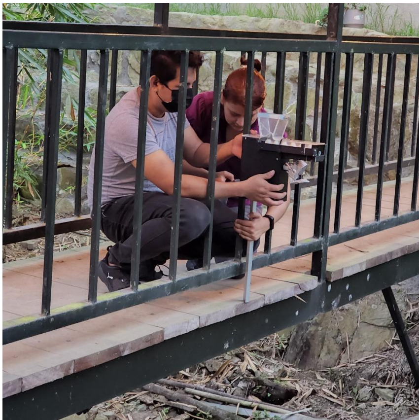
Anexo 6: Proceso de instalación de dispensador
