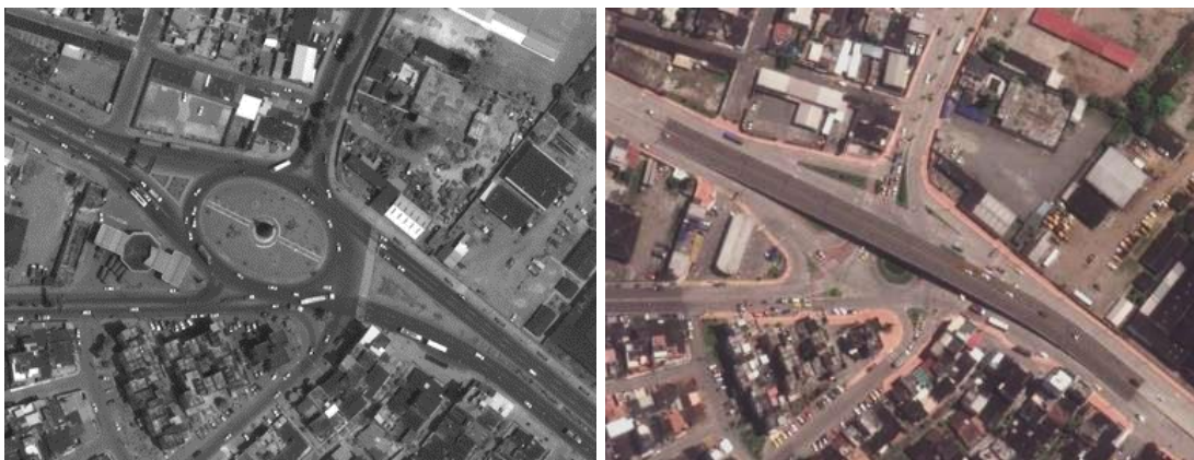
Figura 1 Vista aérea de la intersección Av. 25 de junio y Circunvalación Norte, Machala. 2008 (izquierda) y 2014 (derecha). Fuente: Google Earth
