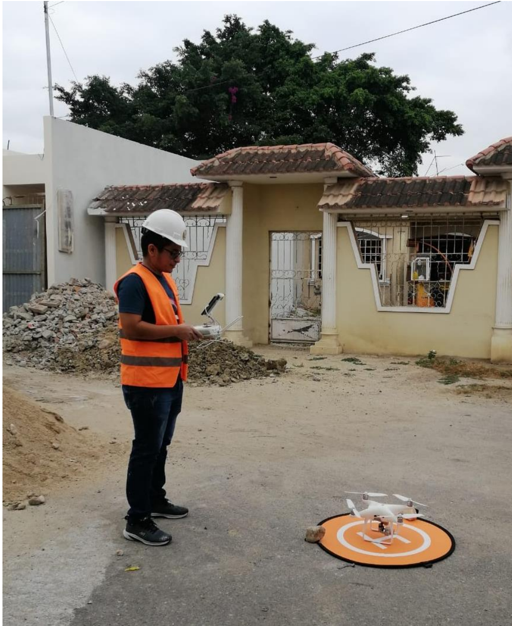
Figura 6: Vuelo del dron para realización del levantamiento. Fuente: Elaboración propia.
