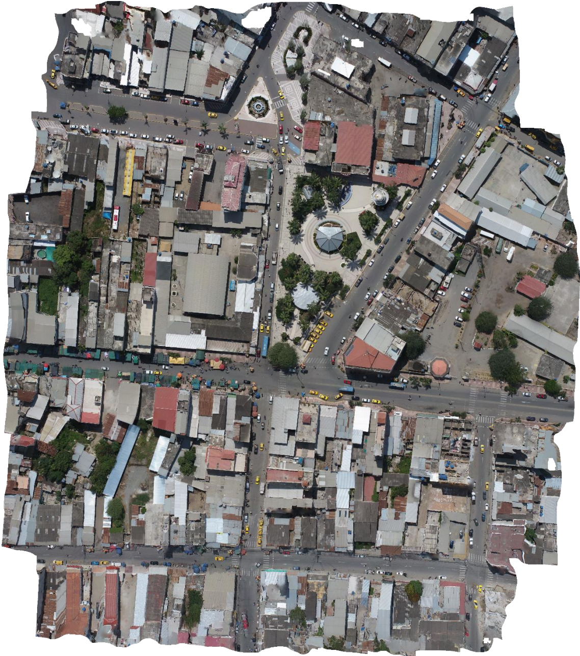
Figura 4: Ortofoto de la intersección levantada con dron. Fuente: Elaboración propia.
