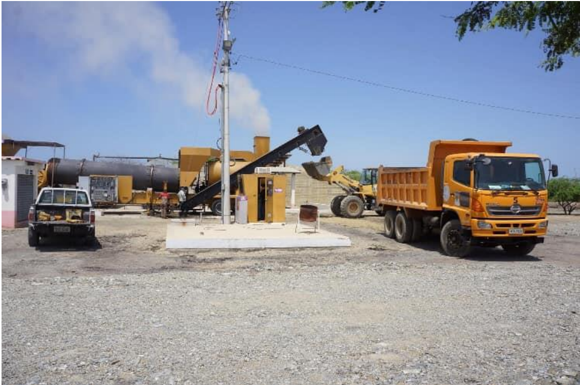
Figura 2: Planta asfaltadora del cantón Huaquillas. Fuente: GADM Huaquillas.
