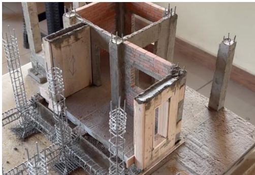
Imagen 45. Colado de hormigón en paredes secundarias
