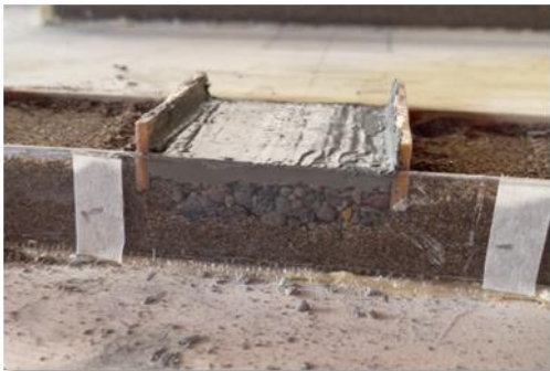
Imagen 15. Foto detallada (Arena, relleno, replantillo)
