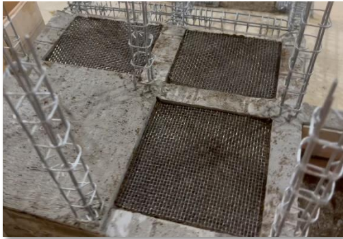
Imagen 31. Colocación de malla electrosoldada para contrapiso
