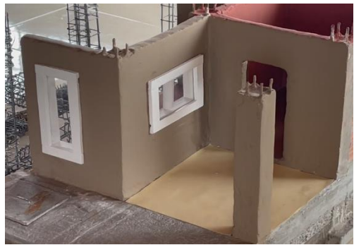
Imagen 51. Colocación de ventanas para comedor y zona exterior
