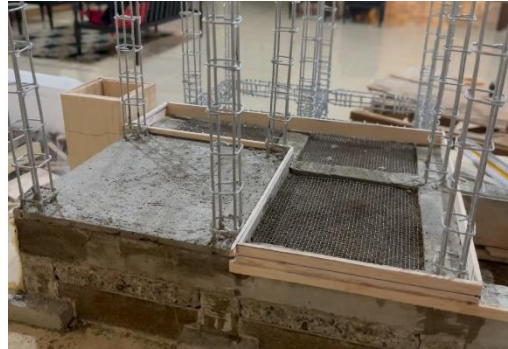
Imagen 32. Encofrado para contrapiso
