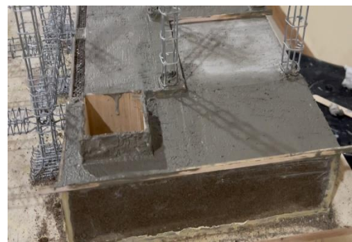
Imagen 36. Colado de hormigón para piso exterior
