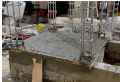
Imagen 30. Colado de hormigón para piso
