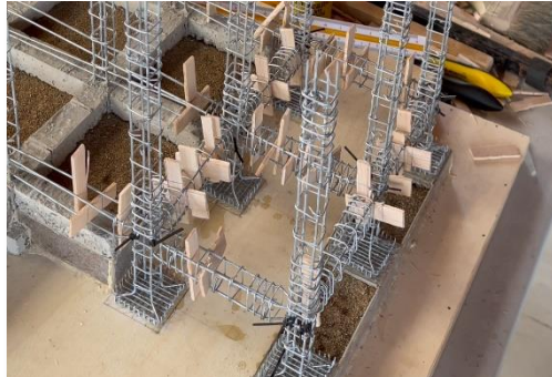
Imagen 22. Armado de vigas junto a sus estribos
