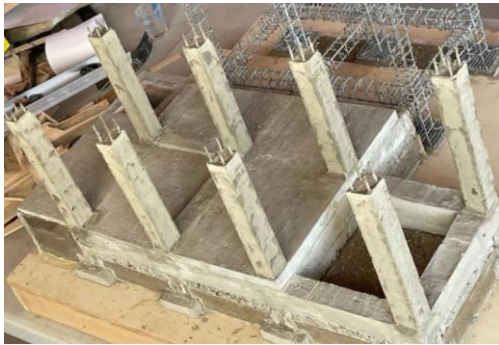
Imagen 39. Desencofrado de columnas
