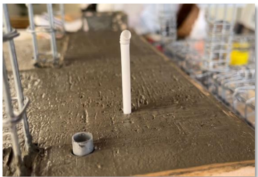
Imagen 34. Colocación de tuberías sanitarias
