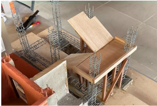
Imagen 55. Encofrado de escalera
