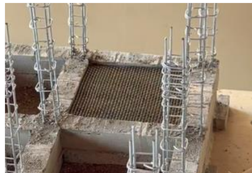
Imagen 28. Colocación de malla electrosoldada para piso
