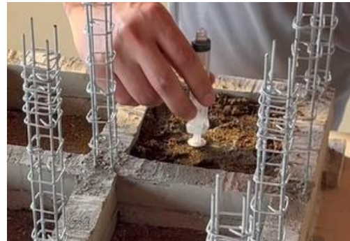
Imagen 26. Hidro-compactación del suelo
