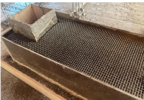
Imagen 35. Ampliación de suelo para caja de registro
