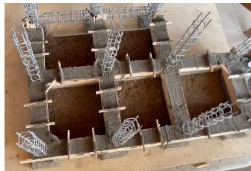
Imagen 24. Colado de hormigón para vigas
