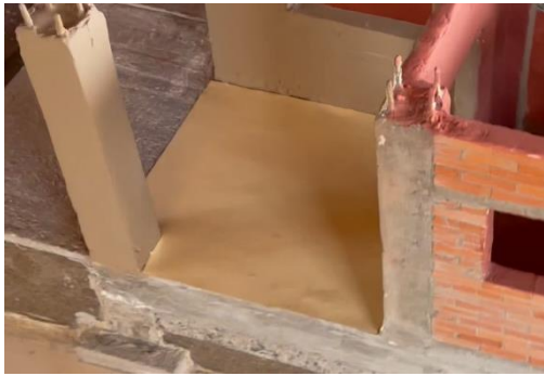
Imagen 49. Colocación de piso para área exterior
