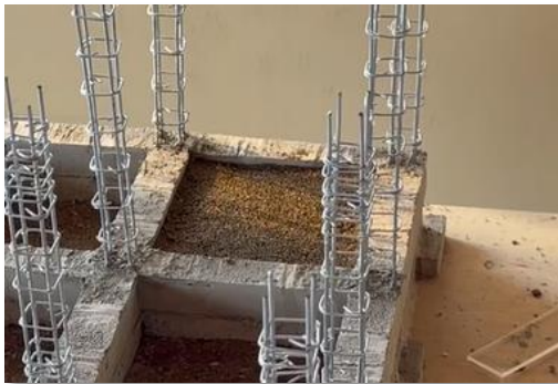
Imagen 27. Hidro-compactación del suelo nivelado
