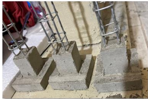
Imagen 8. Desenfofrado de plintos
