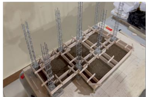
Imagen 16. Encofrado para muro ciclópeo
