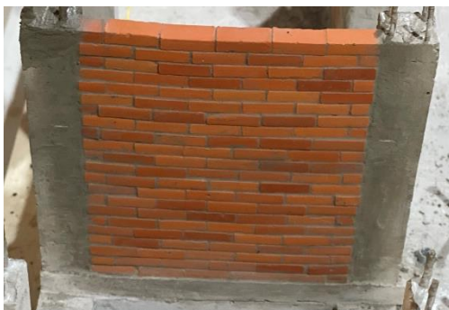
Imagen 41. Mampostería de ladrillos (Muro 1)
