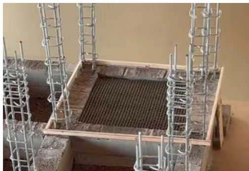
Imagen 29. Encofrado para piso
