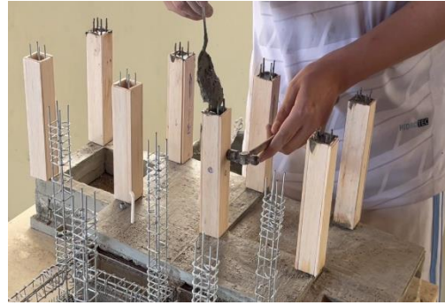
Imagen 38. Encofrado y colado de hormigón para columnas
