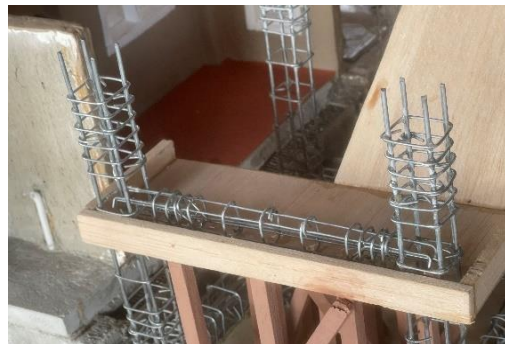
Imagen 56. Armado de viga para escalera
