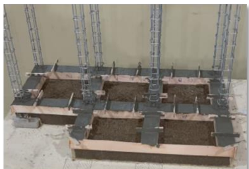
Imagen 17. Colado de hormigón para muro ciclópeo
