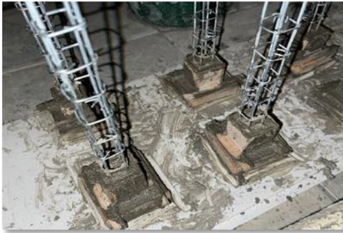
Imagen 7. Colado de hormigón en plintos
