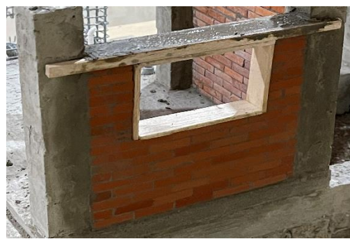
Imagen 42. Mampostería de ladrillos y dintel para la ventana (Muro 2)
