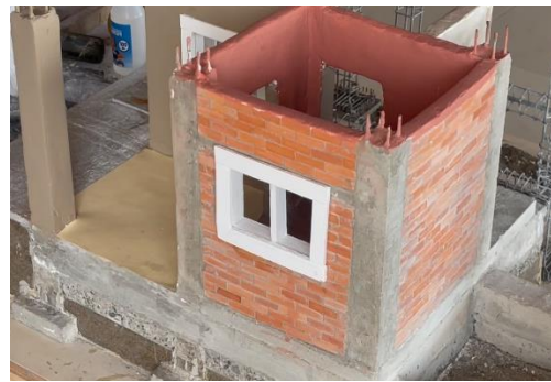
Imagen 52. Colocación de ventanas para cocina
