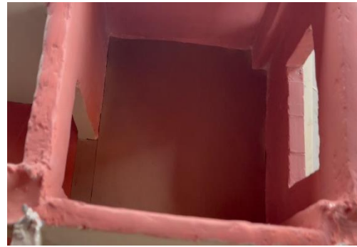
Imagen 50. Colocación de piso para cocina
