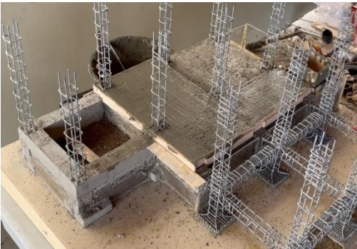
Imagen 33. Colado de hormigón para contrapiso
