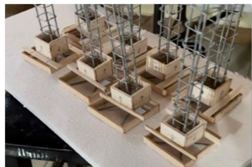
Imagen 6. Encofrado de plintos para columnas
