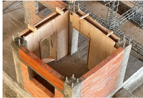
Imagen 44. Encofrado para muro o paredes secundarias
