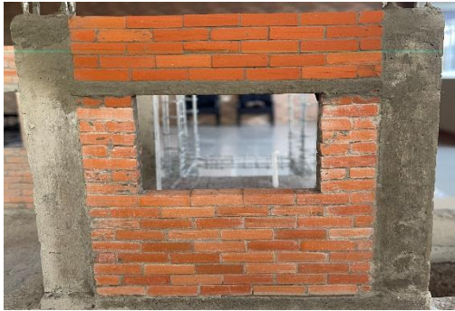
Imagen 43. Mampostería completa de ladrillos (Muro 2)
