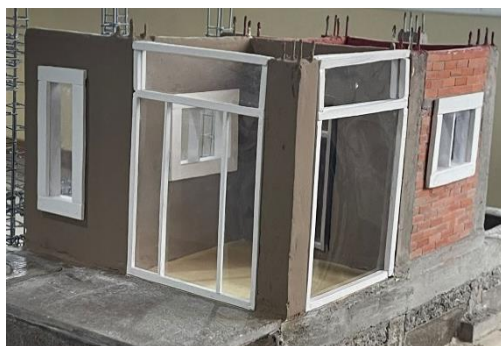
Imagen 54. Colocación de ventanales exteriores
