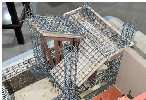
Imagen 57. Armado de Escalera
