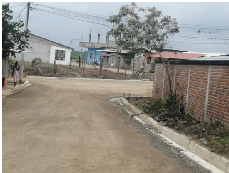
Estado de Vías secundarias 16
