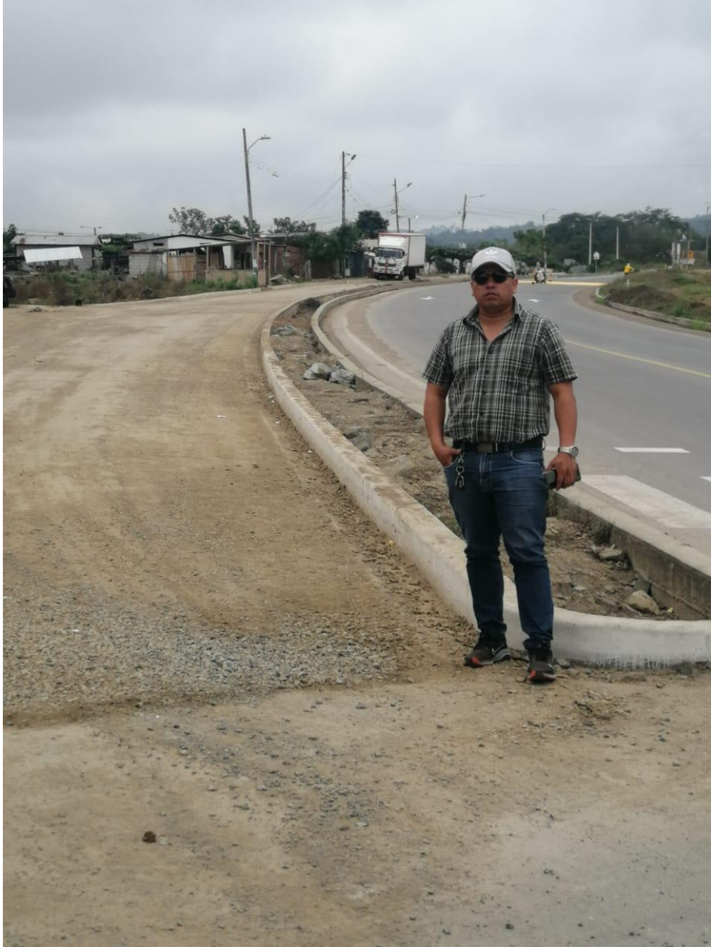
Estado de la vía principal
