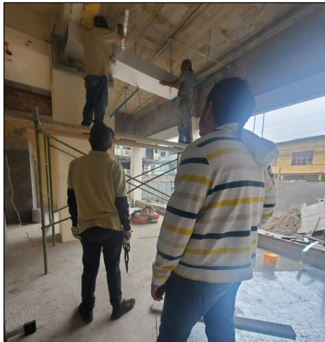
Imagen 2.4 Instalación de Ducto para aire acondicionado en área de tesorería
