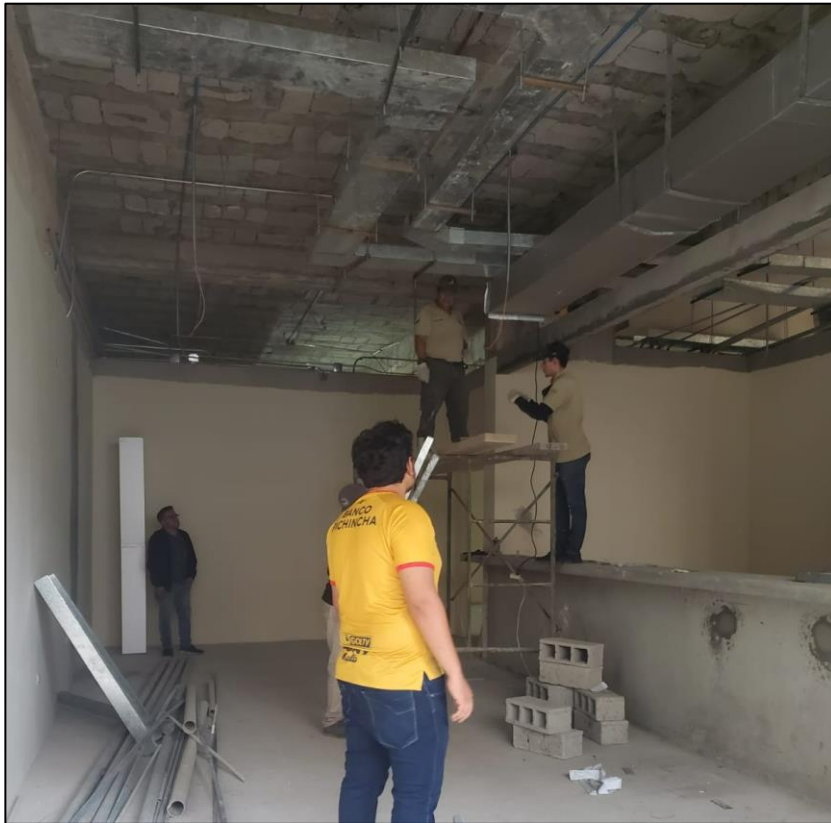
Imagen 2.5 Instalación de Ducto para aire acondicionado en Área de Facturación.
