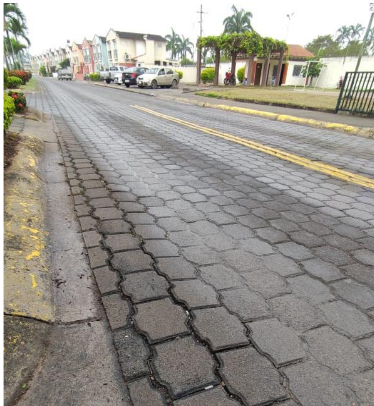
Ilustración 5. Pavimento articulado, Santa Inés
