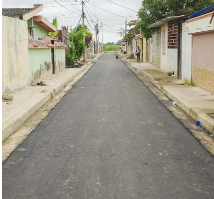
Ilustración 4. Pavimento flexible, barrio San Francisco
