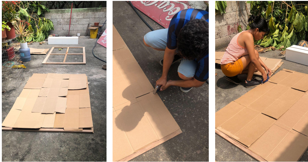
Imagen 17. Comienzo de distribución y fijación de los cartones en la estructura. 2022
