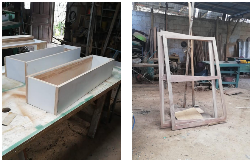
Imagen 14. Construcción de la base y bastidor en madera. 2022
