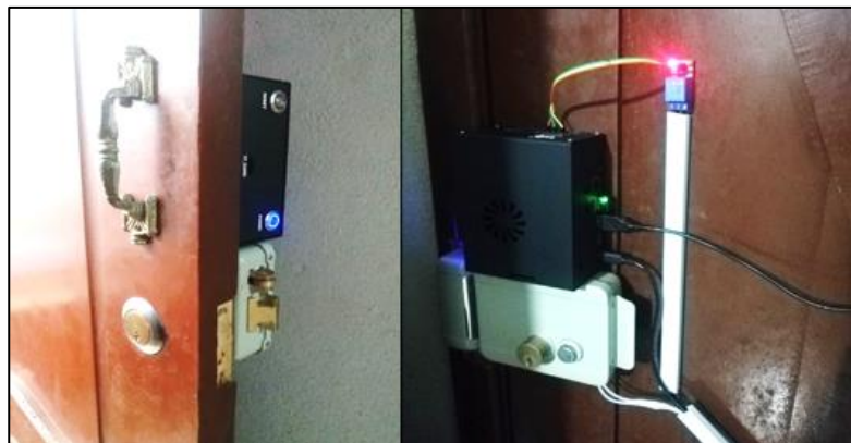
Figura 51. Instalación de chapa eléctrica.
