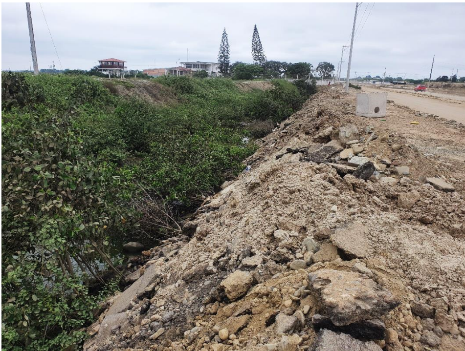
Desalojo de material y escombros en el canal
