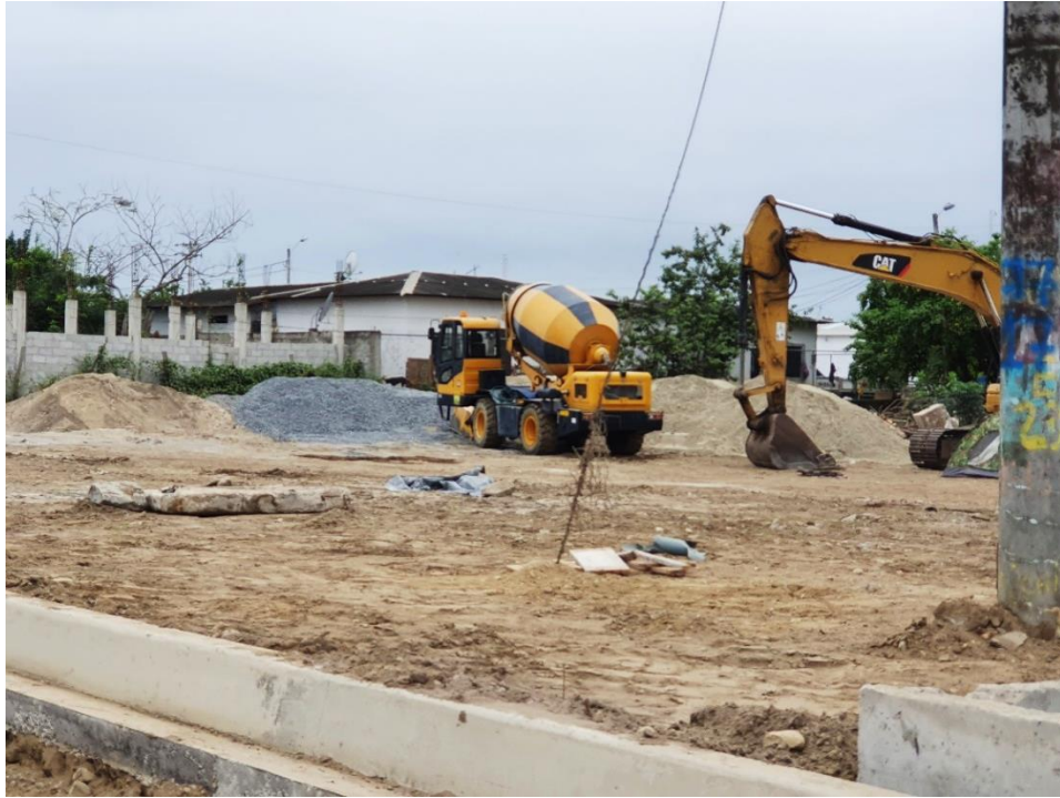
Equipo caminero en obra
