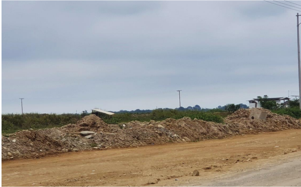
Escombros y material desbrozado al costado de la vía
