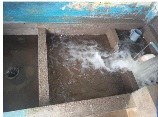
Imagen 10 Mezcla del agua filtrada con el agua clorada.
