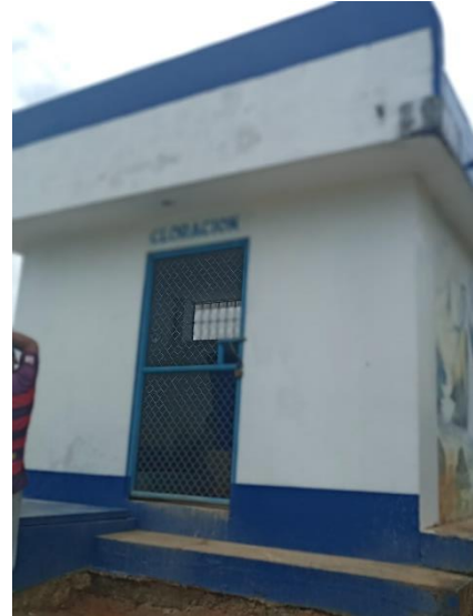
Imagen 8 Caseta de cloración.
