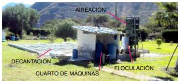
Imagen 17. Planta de tratamiento para agua de bebida de las aves Fuente: (2).
