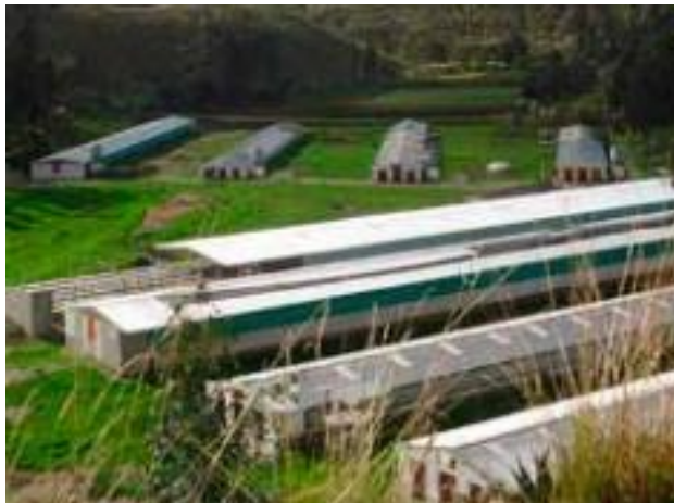
Imagen 6. Construcción con techo de dos aguas.
