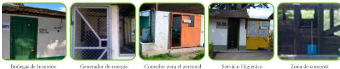
Imagen 10. Algunas de las instalaciones del área limpia.
